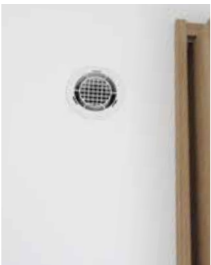
施工イメージ
