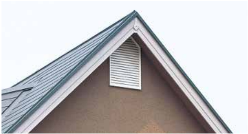
施工イメージ
