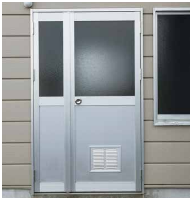
施工事例（室外側）
