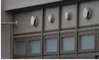
施工写真（学校）
