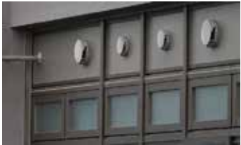
施工写真（学校）
