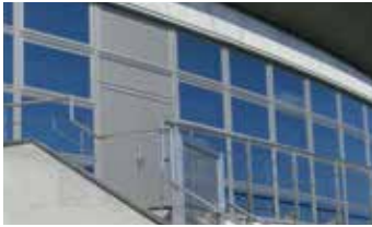
施工写真（体育館）
