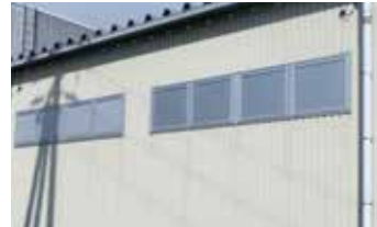
施工写真（倉庫）
