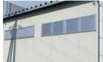
施工写真（倉庫）
