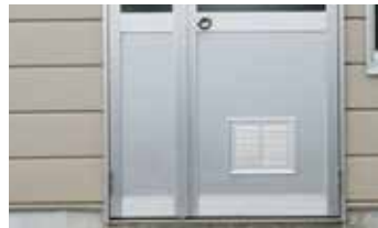
施工写真（公民館）
