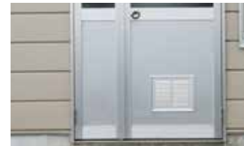
施工写真（公民館）
