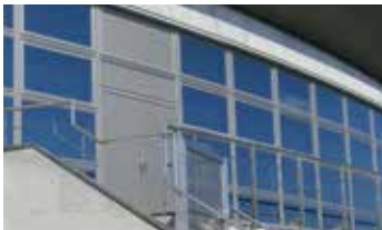
施工写真（体育館）
