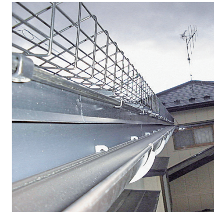
2 既設の雪止め金具を利用し設置。
