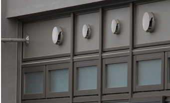
施工写真（学校）
