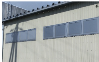
施工写真（倉庫）
