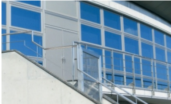
施工写真（体育館）
