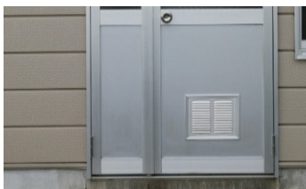
施工写真（公民館）
