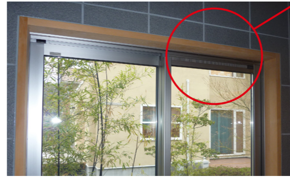
既存の窓に付いている換気ブレス(上框一体タイプ) ※ 換気ブレスは別体タイプの場合もあります。
