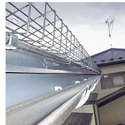
2 既設の雪止め金具を利用して設置。
