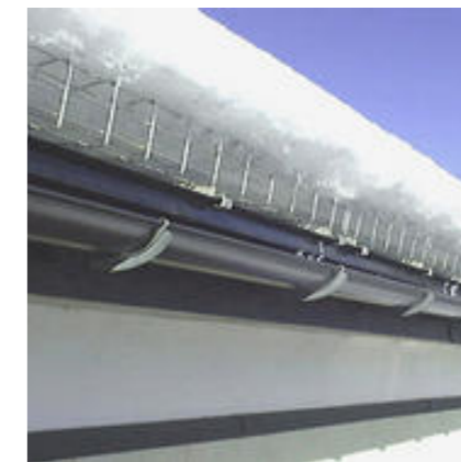
3 屋根に積もった雪が一気に落下する事なく、落雪事故防止に効果的。
