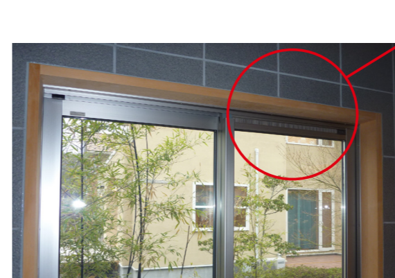
既存の窓に付いている換気プレス(上框一体タイプ) ※ 換気プレスは別体タイプの場合もあります。
